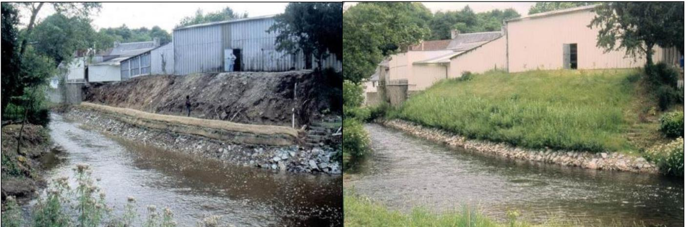
Figure 105. Exemple de chantier de restauration et stabilisation de berges au moyen de techniques mixtes : empierrement sous-fluvial et lits de plants et plançons renforcés par des boudins de géotextile. Etat de l'ouvrage en cours de chantier puis six mois après l'achèvement des travaux.
