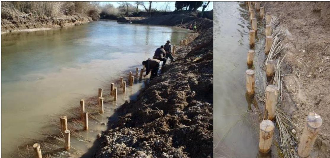
Figure 102. Exemple de réalisation d'une fascine en cours de réalisation
