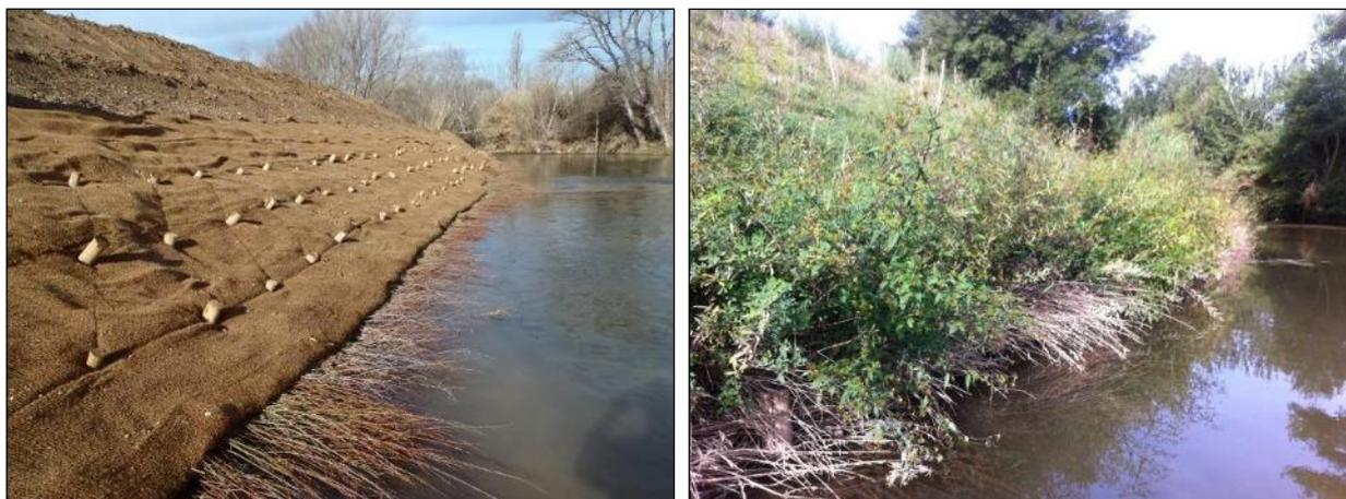
Figure 103. Exemple de réalisation d'une fascine, en fin de travaux photo de gauche et après une saison de végétation photo de droit
